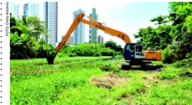
[FOTO&LEGENDA] Em pleno feriado, uma máquina faz a dragagem do rio Jaguaribe, nas imediações da Avenida Epitácio Pessoa, para limpar as águas. Nas proximidades da Avenida Beira-Rio, a remoção do lixo já foi realizada e a área está limpa.
